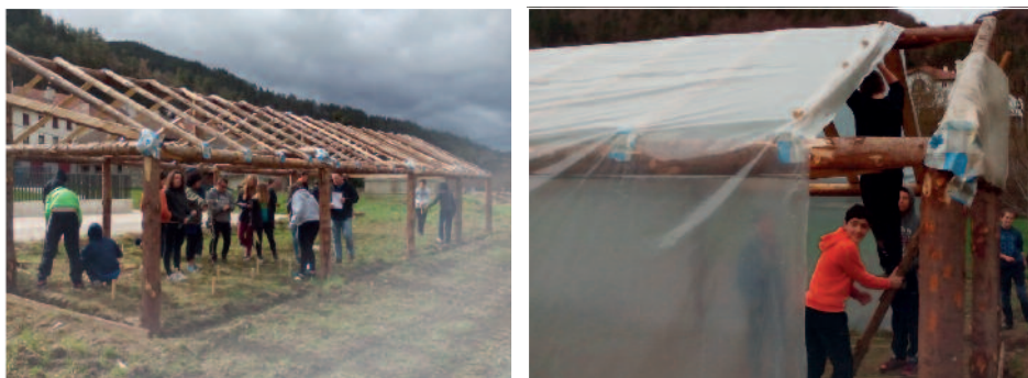
Construcción del invernadero
