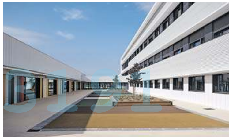
Uno de los patios del edificio.
