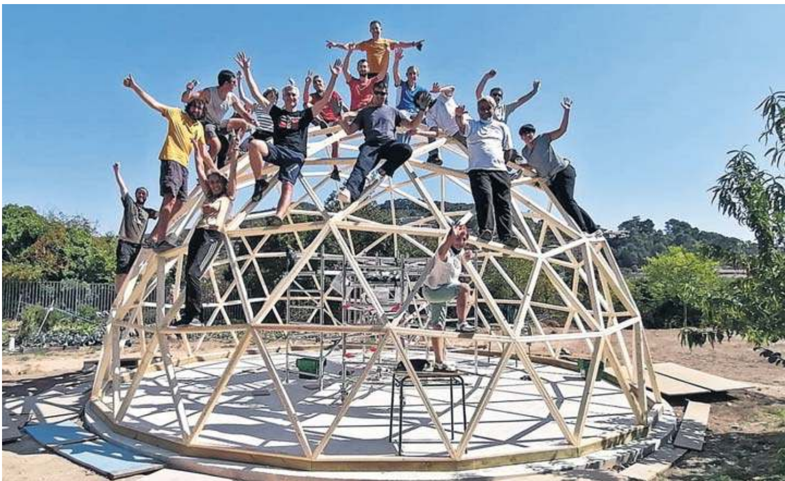
La cúpula geodésica en su última fase de construcción que tuvo lugar en el inicio de curso en el patio del IES Tierra Estella.
